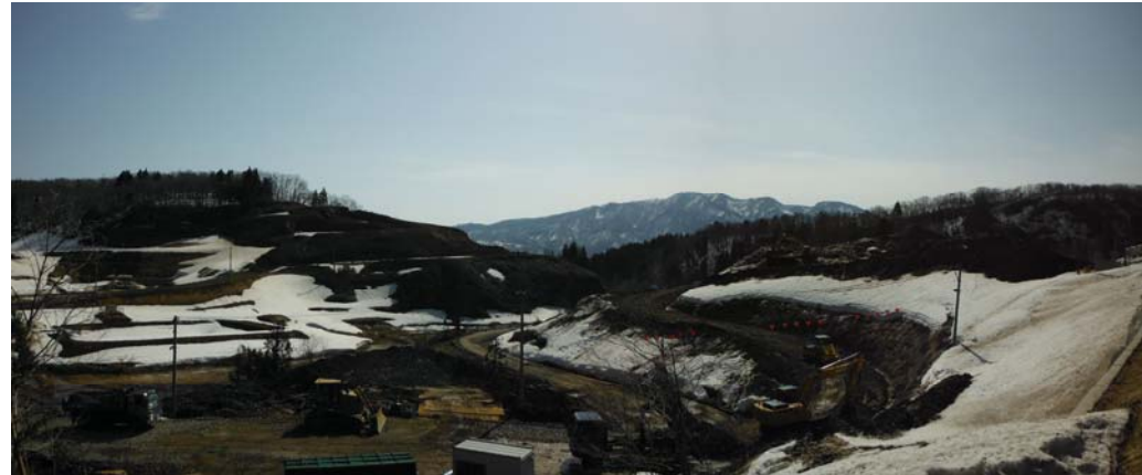
右岸上流からダムサイトを望む(25年4月9日撮影)
