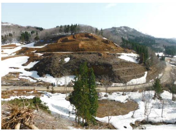
右岸天端から左岸天端を望む(25年4月9日撮影)
