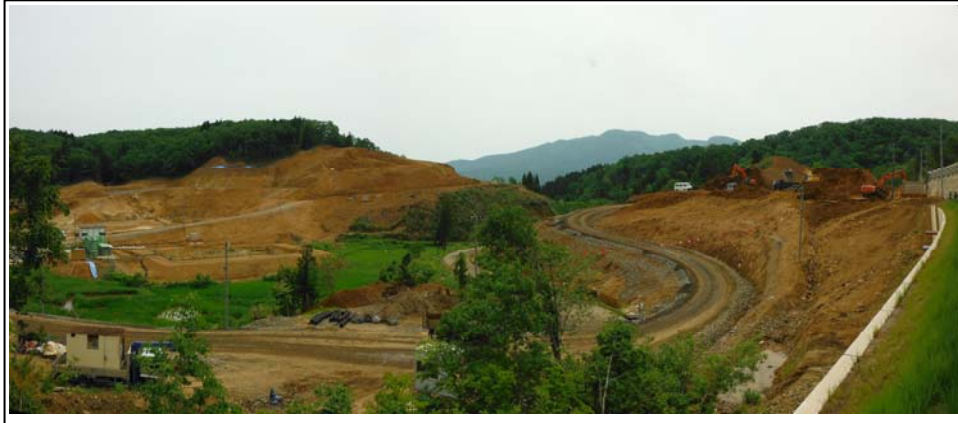
右岸上流からダムサイトを望む(25年5月30日撮影)
