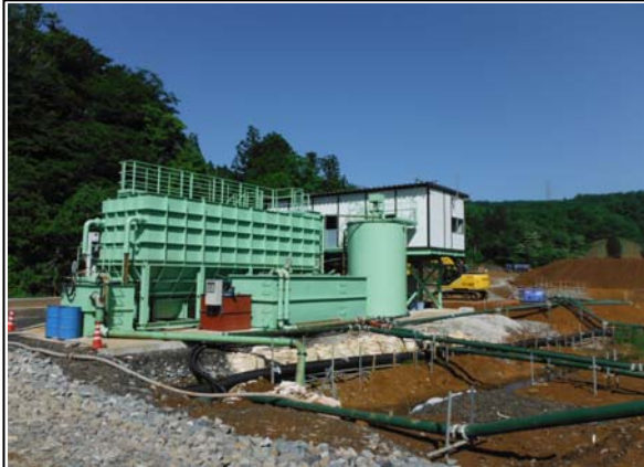
濁水処理プラントを増設しました。 (25年5月30日撮影)
