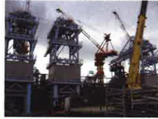
白根ポンプ場建設工事の様子
