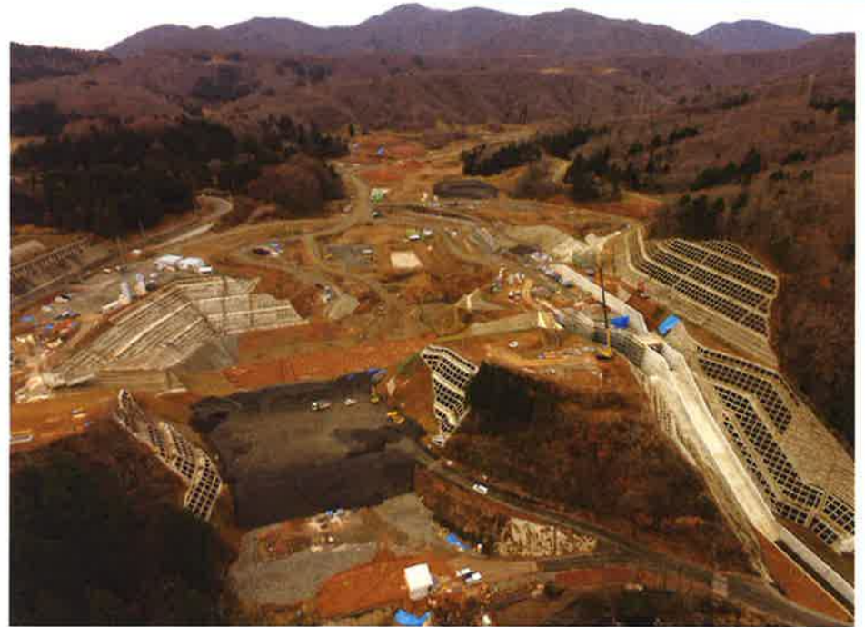
下流よりダムサイトを望む(ドローン撮影)
