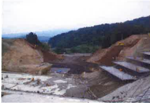
堤体上流より堤体基礎掘削状況
