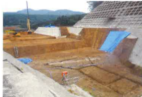
洪水吐上流側基盤検査箇所
