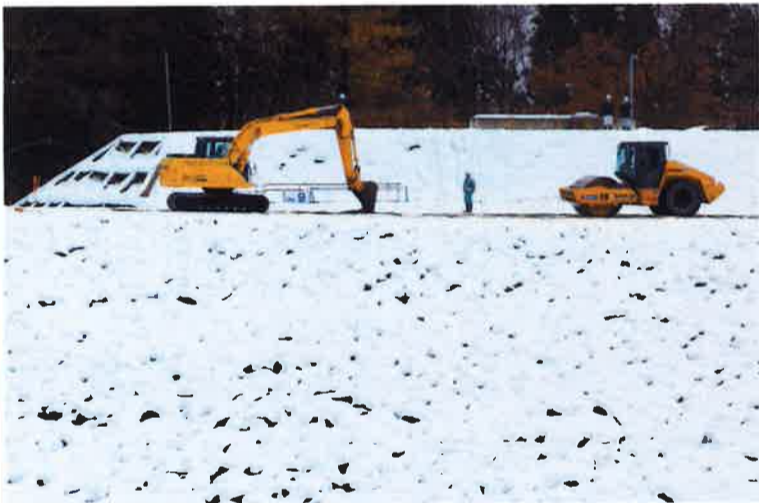
最後の盛立材料を重機で敷均し締め固める
